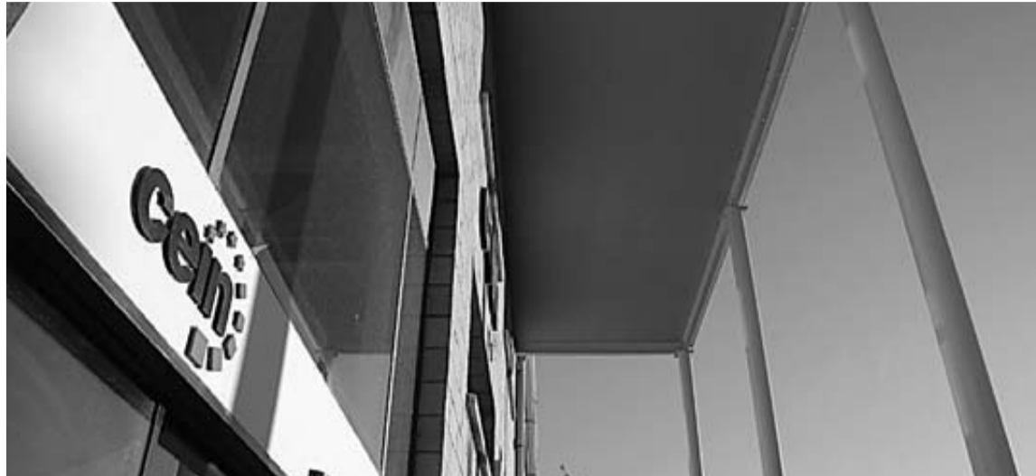
Fachada de las instalaciones de Cein, en el polígono industrial Mocholí, en Noáin.
